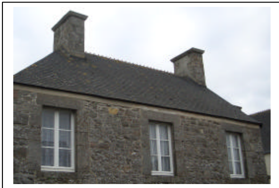
Toiture en ardoises
