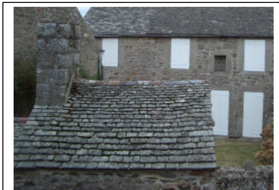
Toiture en Schistes
