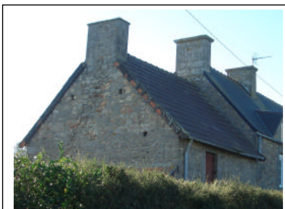
Toiture en tuiles mécaniques
