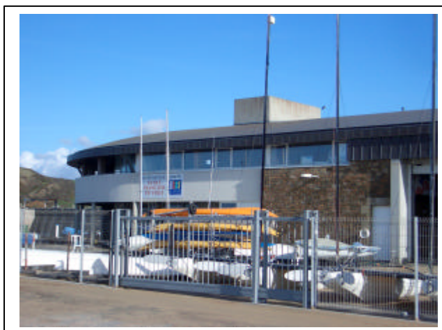
Toiture à faible pente en cuivre
