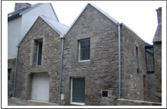
Percements – Croisées à grands carreaux
