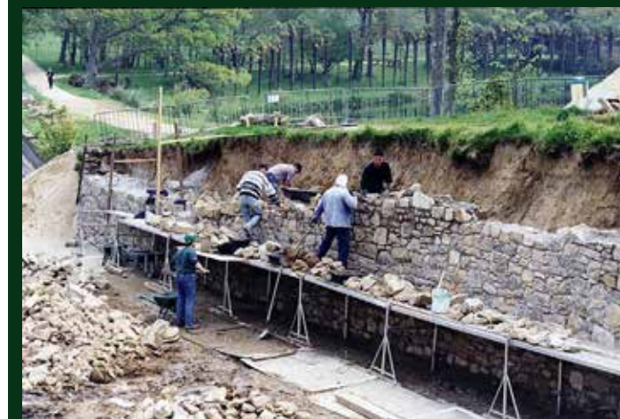
Rénovation des douves du château par les agents communaux
